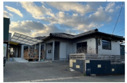
▲完成した第2のはたけの家(仮)の外観
